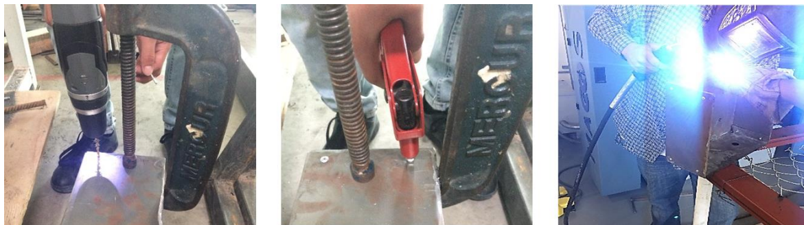
Figura 58. Procesos de perforación (izq.), remachado (centro) y soldadura (der.) de gabinete de control.
