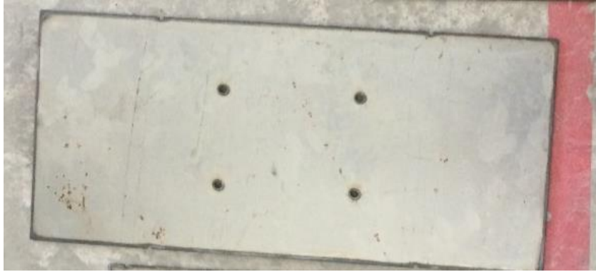
Figura 54. Diseño de la base del gabinete de control con orificios de sujeción.
